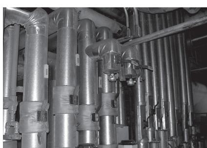
用于主蒸汽疏水的 MOGAS RSVP® 阀门壁厚，性能要优于原始的截止阀。生产中暴露于 950°F, 1875 磅/平方英寸 (510°C, 129 巴) 的环境下，阀门的可靠运行和密封至关重要。
