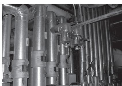
*La pared de las válvulas RSVP de MOGAS para el drenaje de vapor principal, ha mejorado el rendimiento de las válvulas de globo originales. Dado que están expuestas a 950 °F a 1.875 psi (510 °C a 129 bar) cuando están en carga, es fundamental que estas válvulas funcionen y sellen en forma fiable.*
